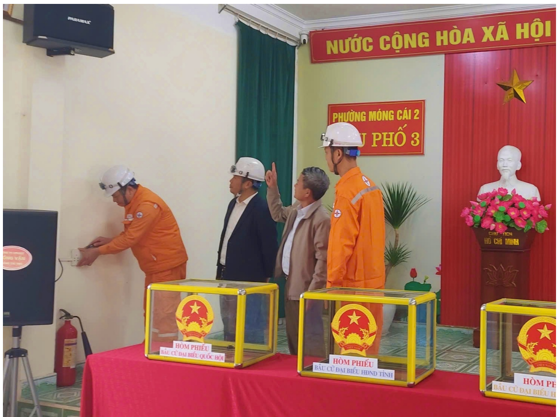
Đội Quản lý Điện lực khu vực Móng Cái kiểm tra đảm bảo cấp điện ổn định an toàn cho các khu vực bầu cử
