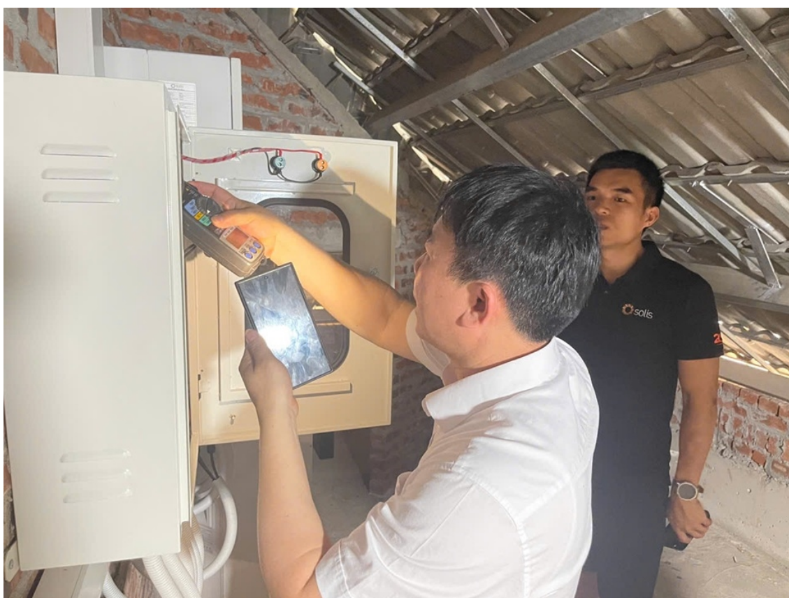
Công ty Điện lực Sơn La phối hợp kiểm tra việc lắp đặt hệ thống điện mặt trời mái nhà tự sản tự tiêu
