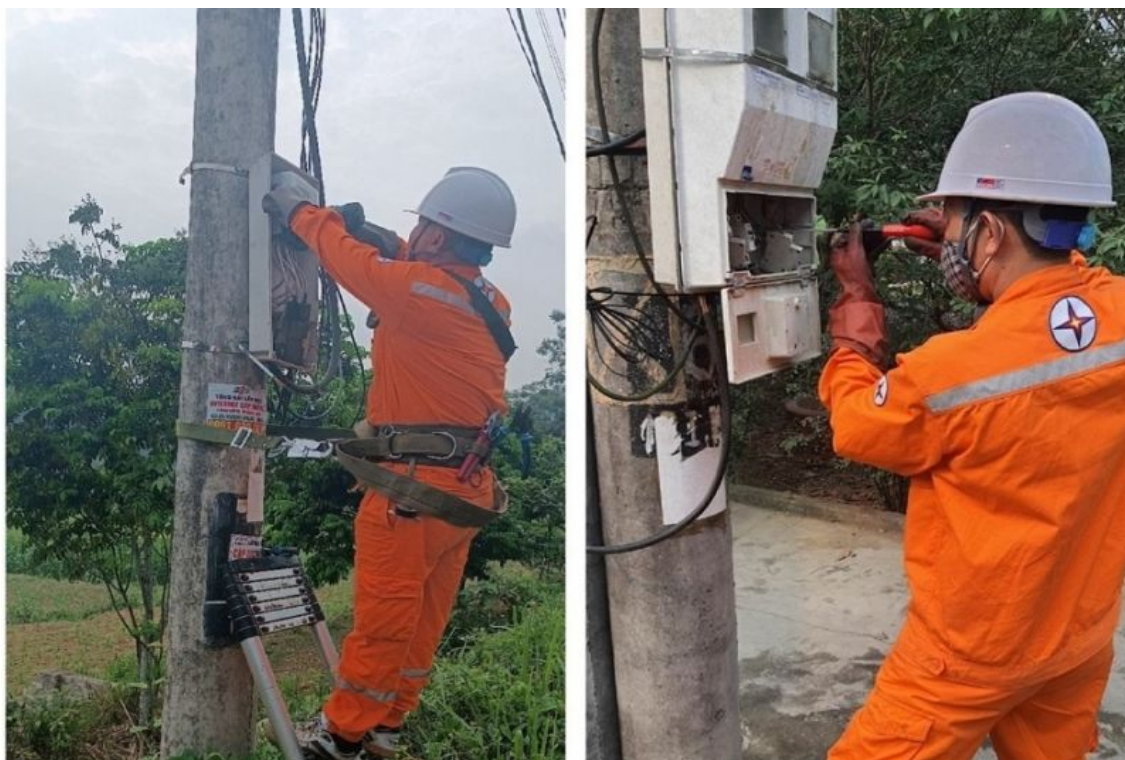
Các cán bộ, công nhân viên thay thế công tơ cơ khí sang công tơ điện tử
