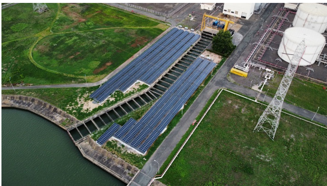
Hệ thống điện mặt trời tại Công ty Nhiệt điện Phú Mỹ.
