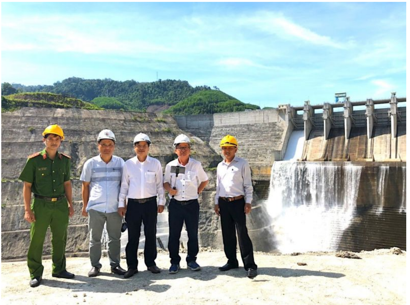
Ban chỉ huy PCTT&TKCN huyện Nam Giang và Công ty kiểm tra hạng mục Đập tràn Nhà máy Thủy điện Sông Bung 4 đảm bảo an toàn khi vận hành xả tràn điều tiết hồ chứa, trong mùa mưa lũ năm 2020
