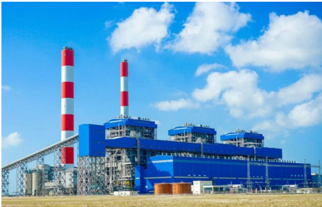
CTCP Tư vấn Xây dựng điện 3
