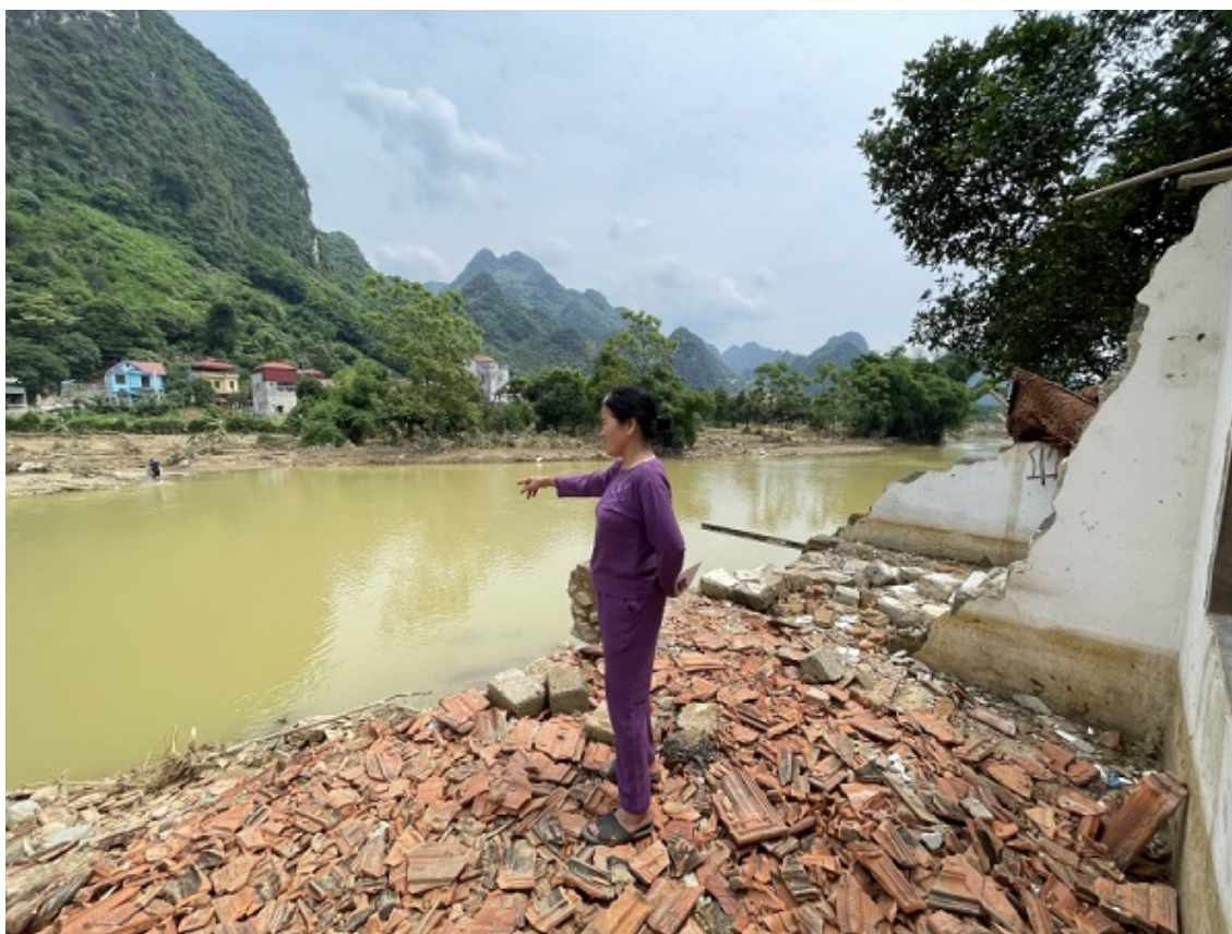
Nhà bà Hoàng Thị Thiếp ( khu Lũng Cút, TT Đồng Mô) bị sập hoàn toàn
