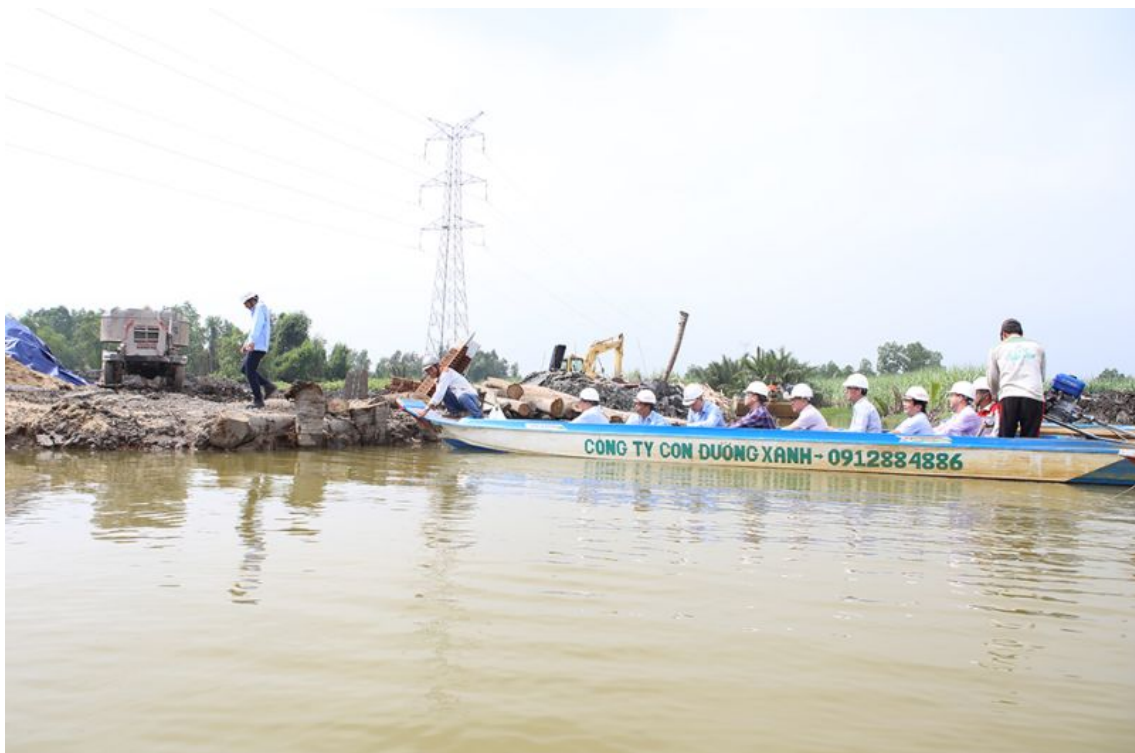
Đoàn công tác kiểm tra vị trí thi công Dự án Đường dây 500kV NMĐ Nhơn Trạch 4 – rẽ Phú Mỹ - Nhà Bè đoạn qua địa phận tỉnh Đồng Nai
