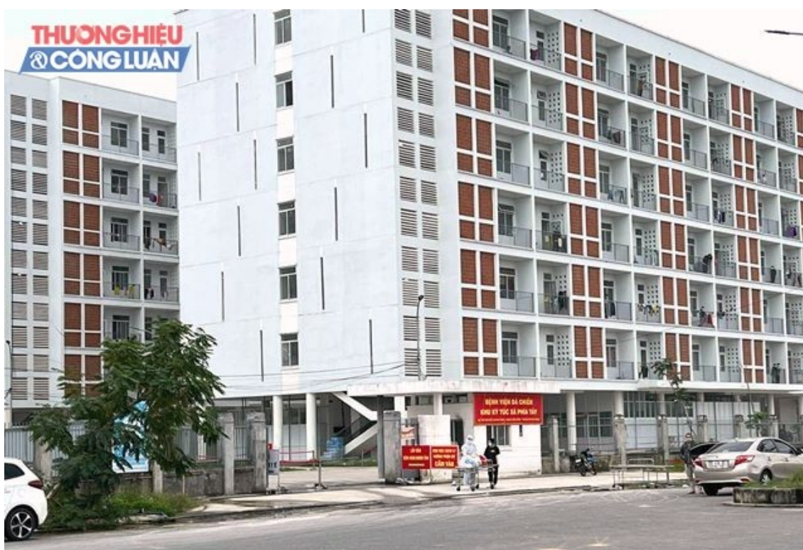
Chuẩn bị cơ sở hạ tầng, kích hoạt bệnh viện dã chiến số 2.
