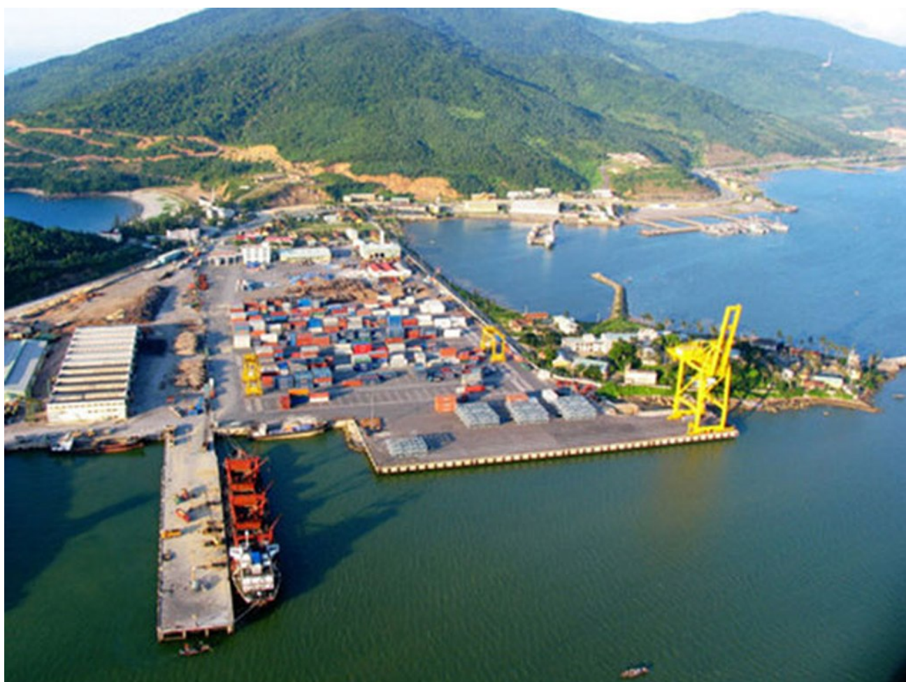
Cảng Liên Chiểu được xây dựng nhằm giảm tải áp lực cho cảng Tiên Sa
