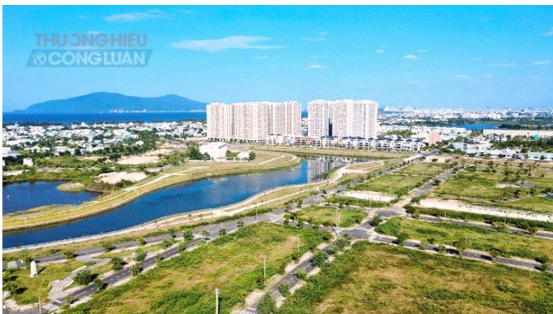
Dự án nhà ở tại phường Hải Vân, TP Đà Nẵng. Ảnh: Hoàng Hữu Gia Bảo.
