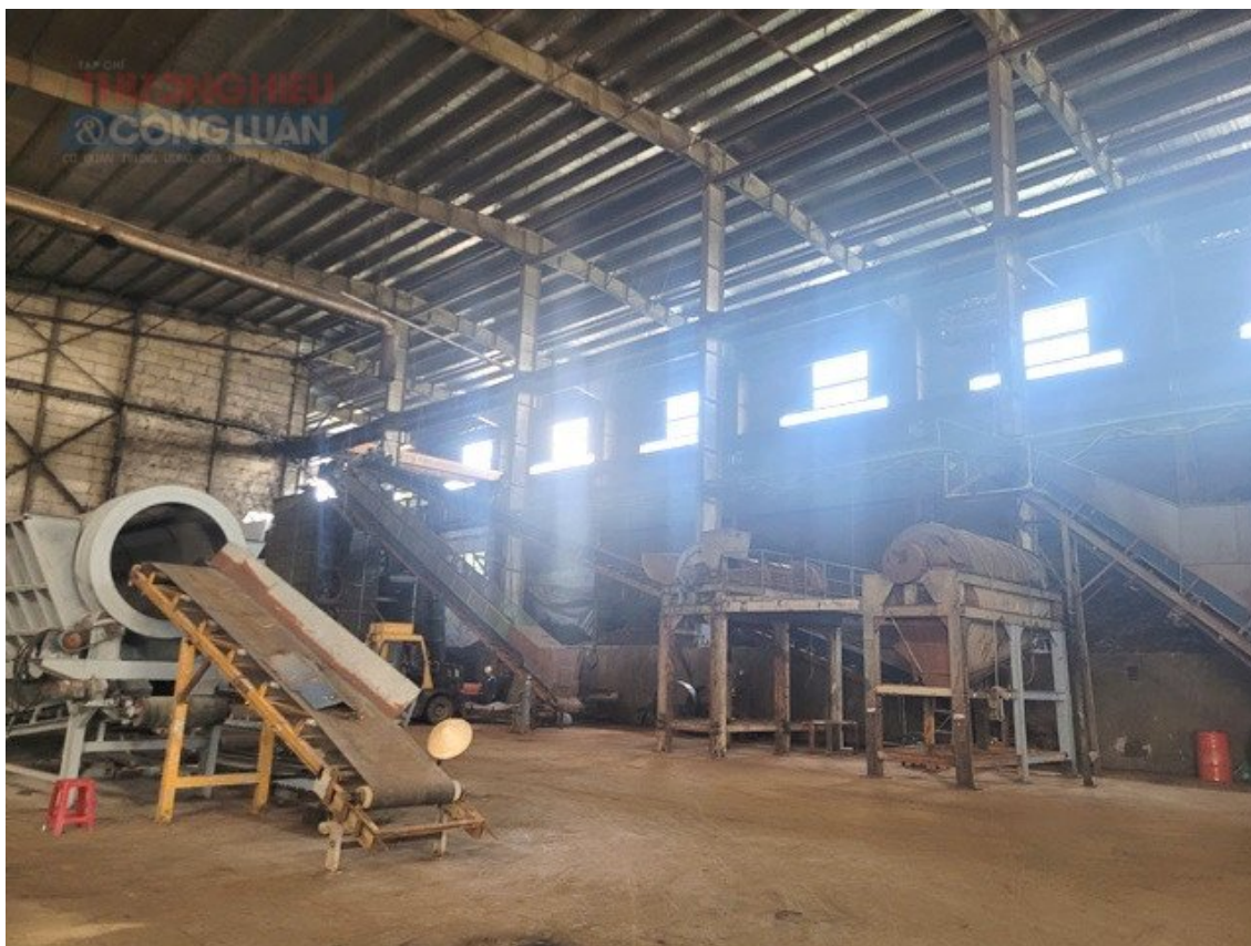
Một góc khu nhà máy xử lý rác.
