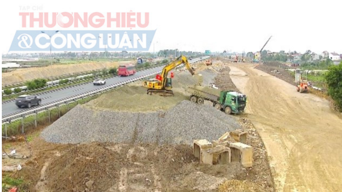
Thi công nâng cấp nút giao quốc lộ 14B với cao tốc Đà Nẵng - Quảng Ngãi
