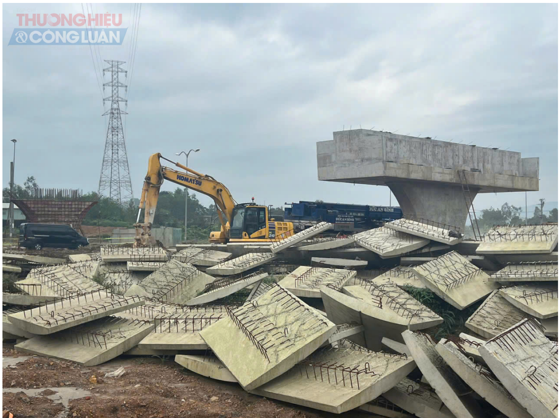
Thi công nâng cấp nút giao quốc lộ 14B với cao tốc Đà Nẵng - Quảng Ngãi
