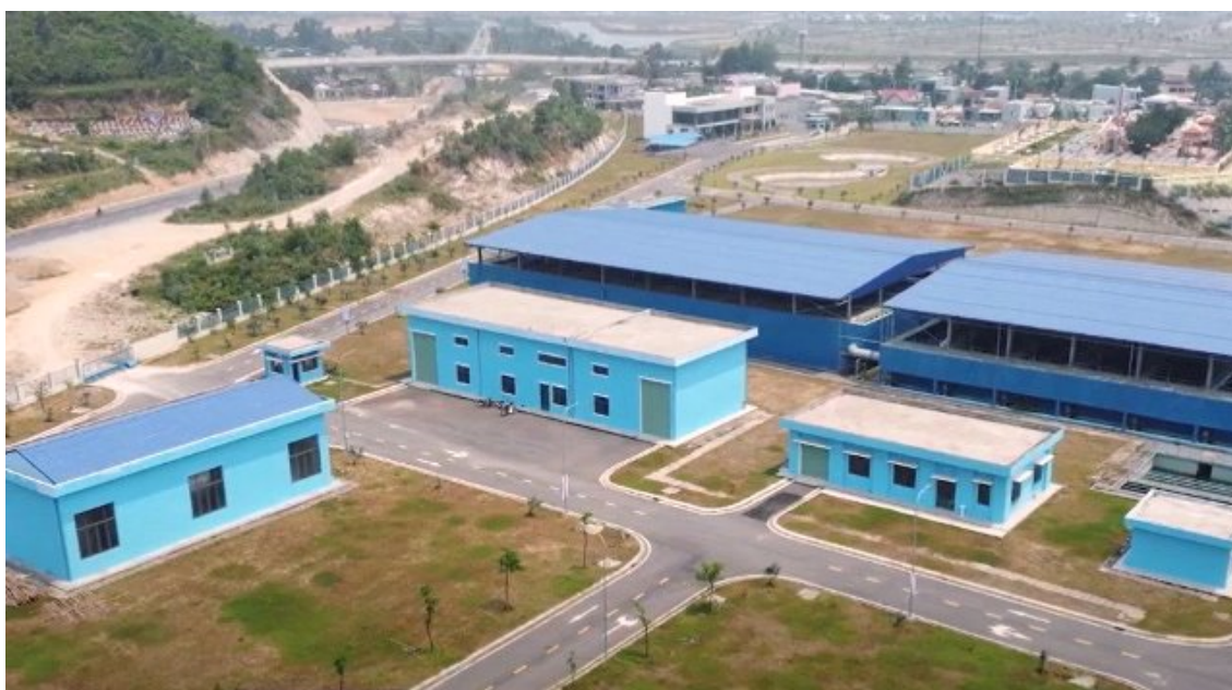
Nhà máy nước Hòa Liên đã được hoạt động
