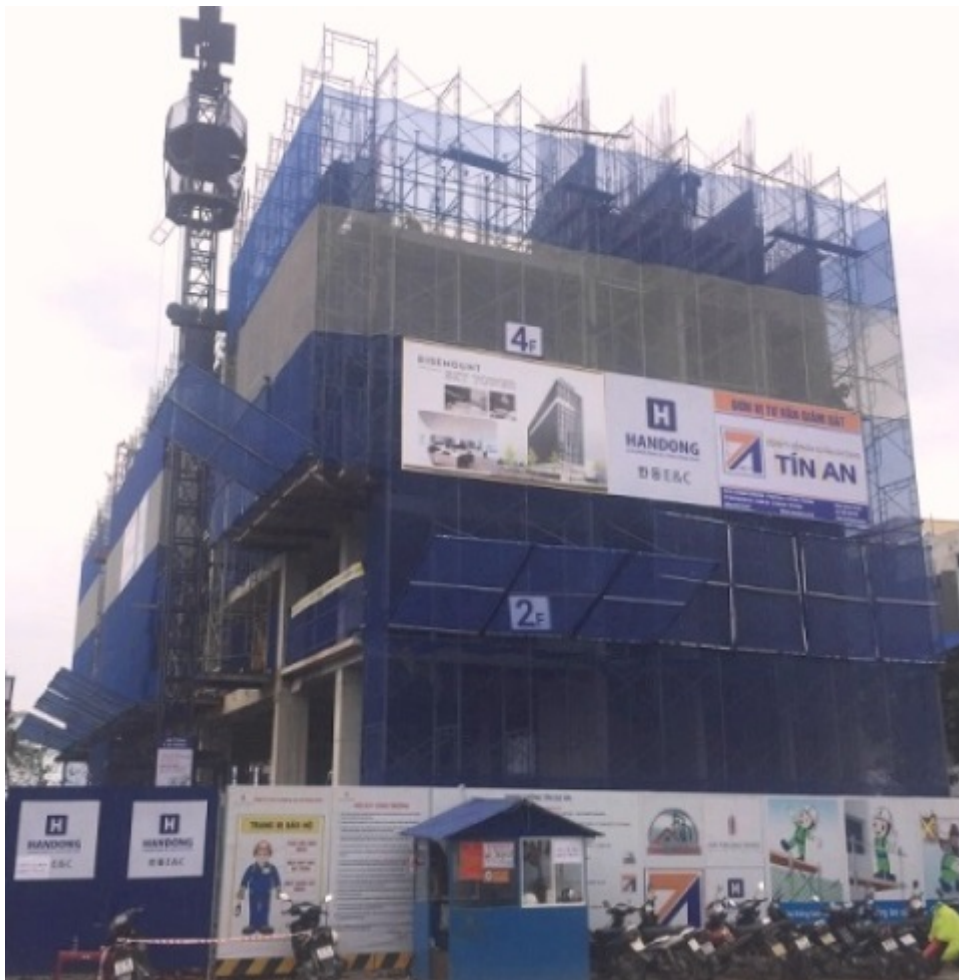
Dự án The Summit Building lúc chưa hoàn thành..
