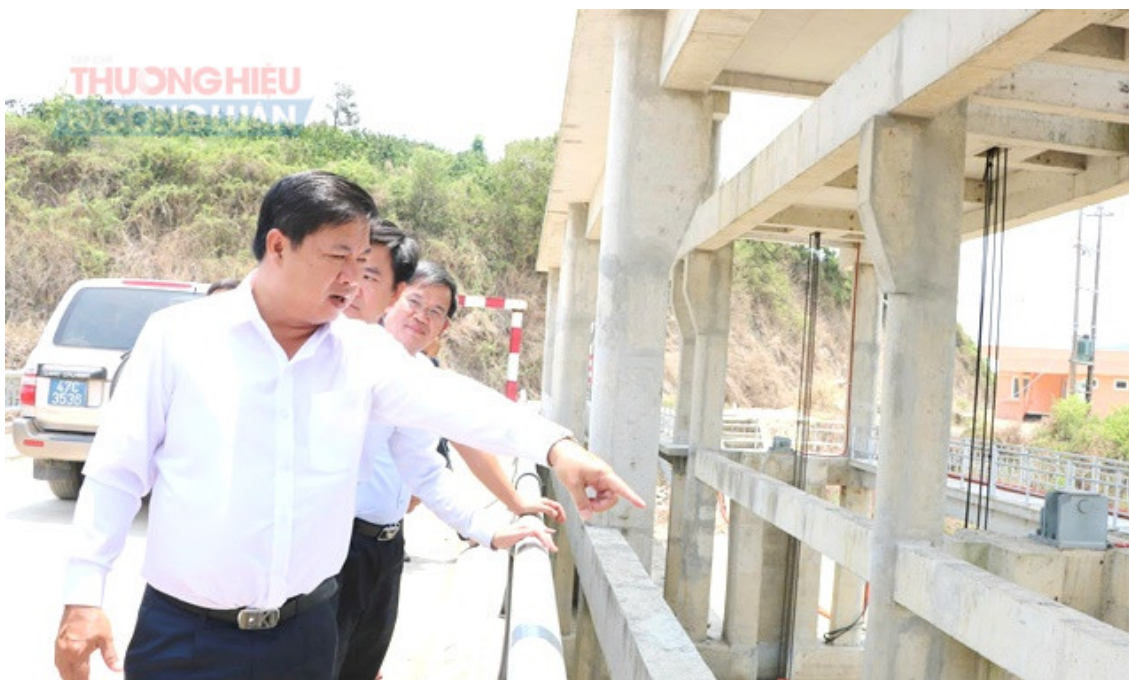
Bí thư Tỉnh ủy Lương Nguyễn Minh Triết kiểm tra thực địa dự án đập ngăn lũ phía Nam sông Krông Ana.
