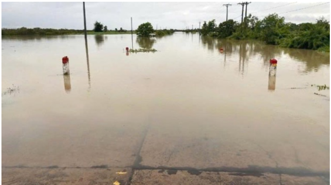
Một tuyến đường trên địa bàn xã Ia Rvê (Đắk Lắk) bị ngập do mưa lớn.
