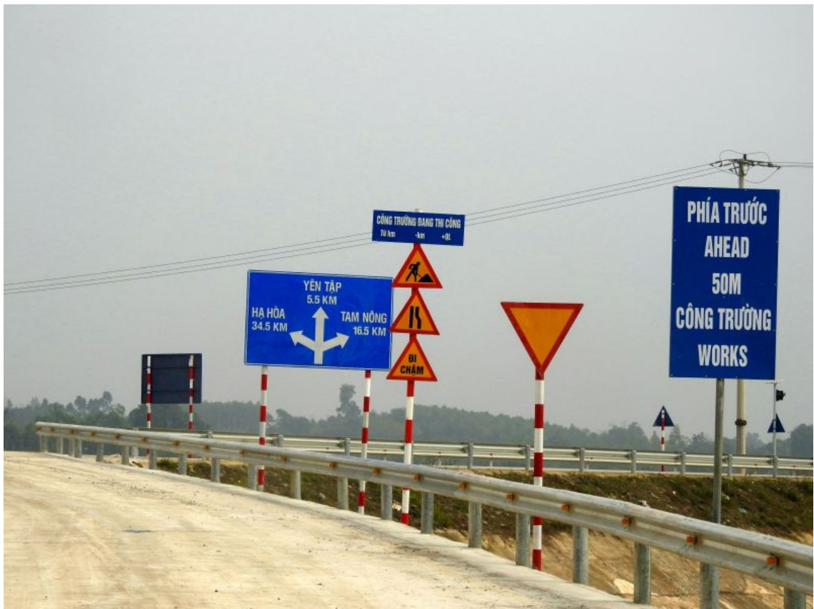
Lắp đặt hệ thống biển báo chỉ dẫn giao thông
