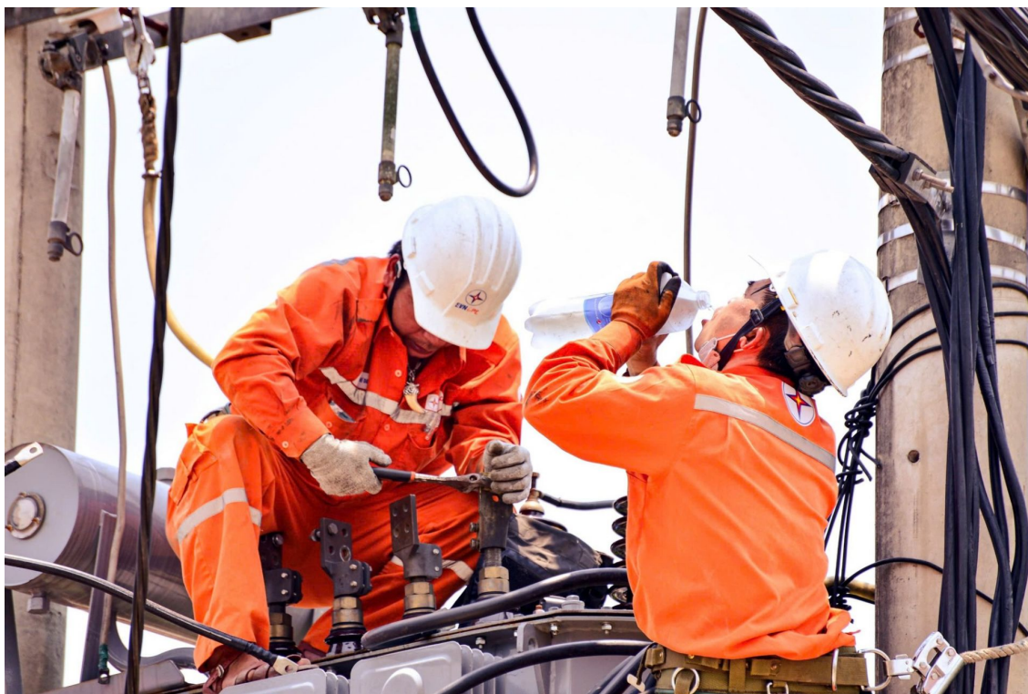
Sửa chữa điện mùa nắng nóng
