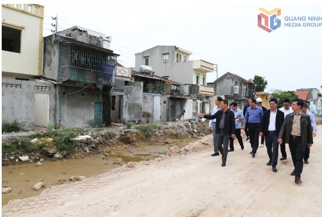
Đoàn công tác kiểm tra việc GPMB phục vụ thi công dự án. (Ảnh: QMG)
