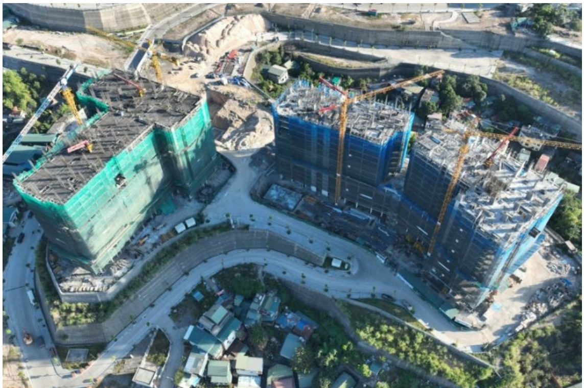
Dự án Khu nhà ở xã hội thuộc Khu dân cư đôi Ngân hàng (Thành phố Hạ Long, tỉnh Quảng Ninh) do Agribank cấp tín dụng
