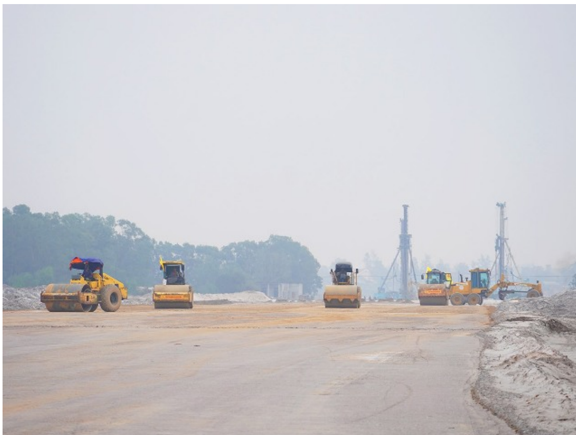
Các đơn vị đang tập trung thi công đường cát, hạ cánh Cảng hàng không Quảng Trị. (Ảnh: T.N)
