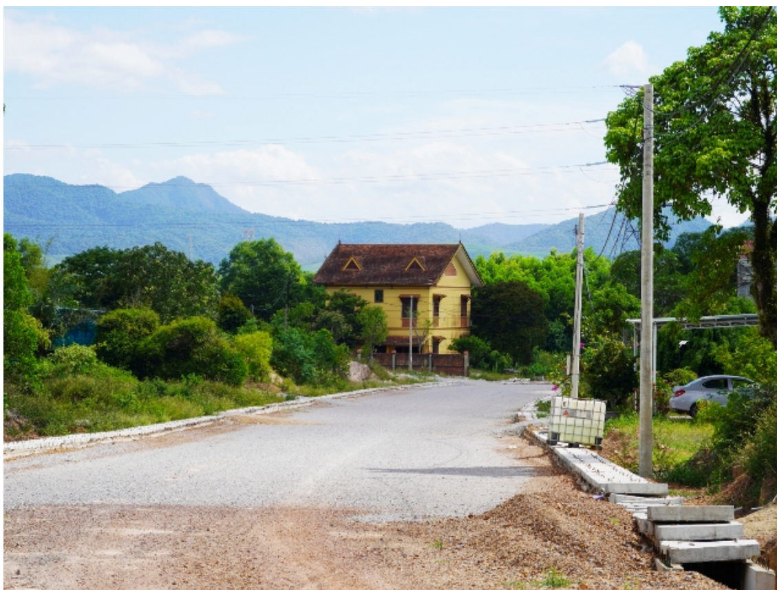
Công trình Đường nối từ đường nối từ đường tránh Quốc lộ 1 với nhánh Đông đường Hồ Chí Minh còn vướng mắc về công tác GPMB.
