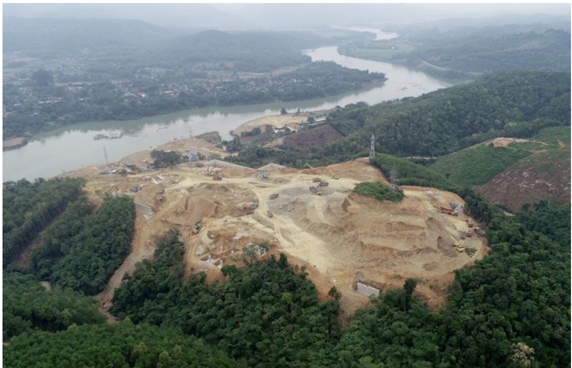
Toàn cảnh công trường thi công TBA 220kV Tương Dương (Nguồn: https://petrotimes.vn/ )
