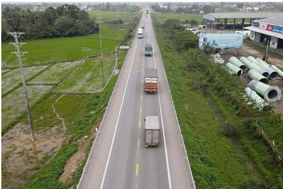
Một đoạn tuyến tránh TP Hà Tĩnh (cũ), tỉnh Hà Tĩnh. (Ảnh: TQ)
