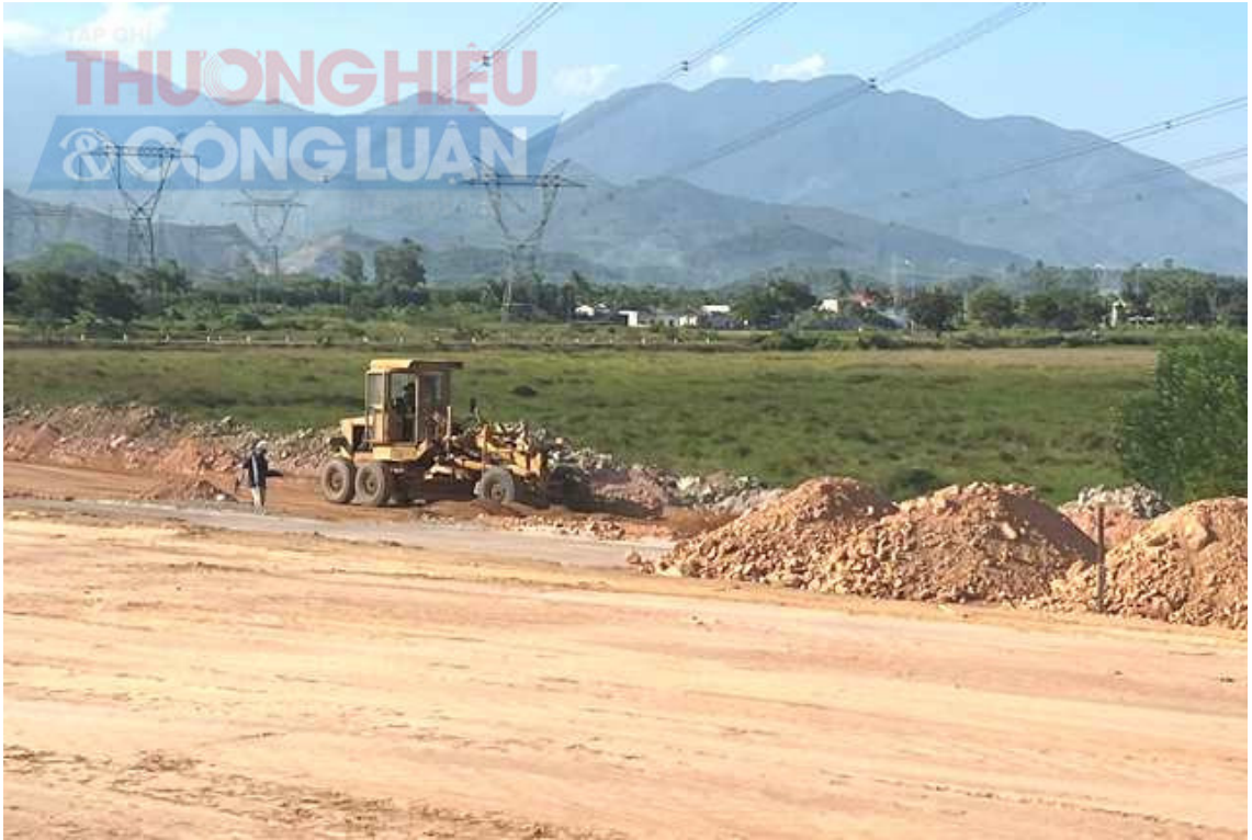
Đoạn cao tốc Hòa Liên - Túy Loan đang được thi công
