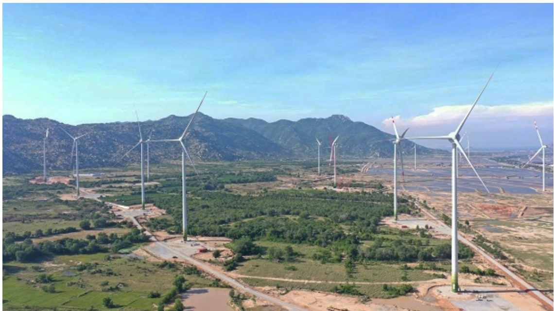
Dự án điện gió 7A
