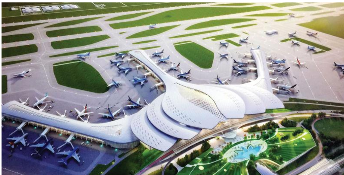
Phần đầu hoàn thành Cảng Hàng không quốc tế Long Thành vào quý I/2025. Ảnh chinhphu.vn.
