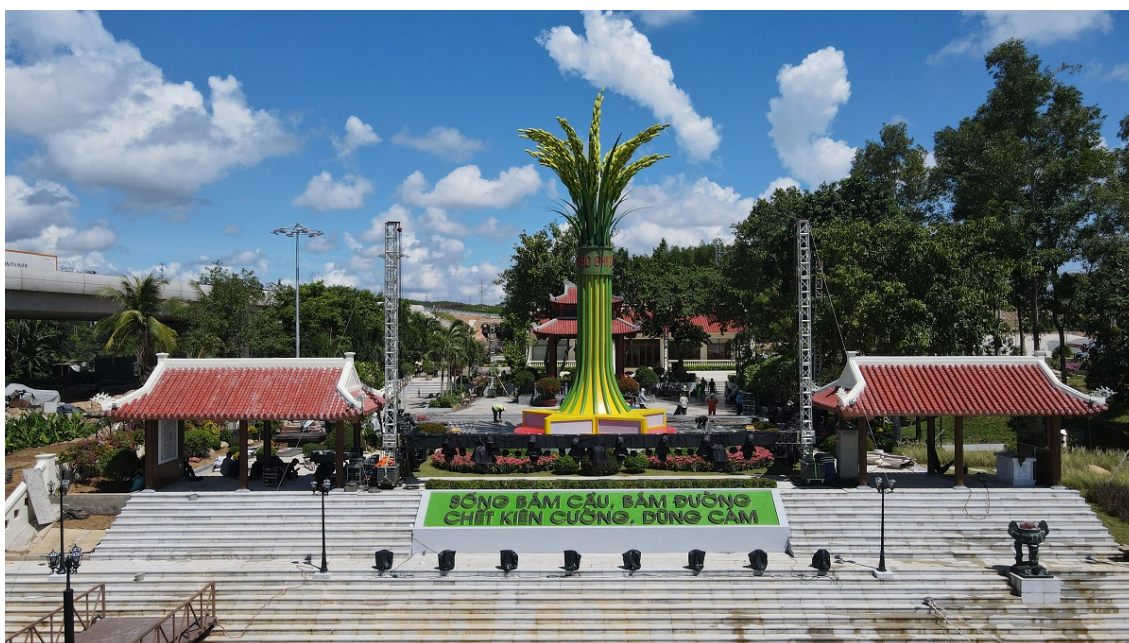
Công trình tôn tạo Khu tưởng niệm nơi hy sinh của 16 thanh niên xung phong (tháng 9/1972) tại Bến phà 2 Long Đại
