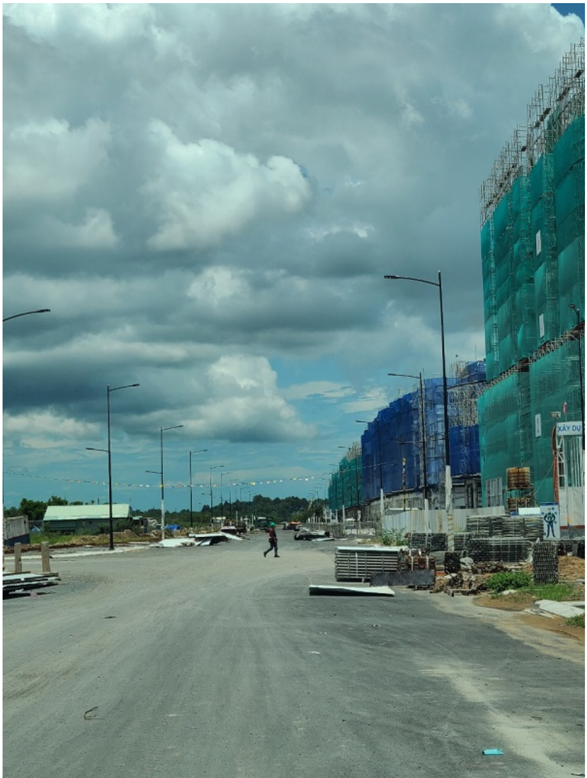
Bất chấp dịch bệnh, dự án vẫn đang gấp rút thi công. (Ảnh: HD)
