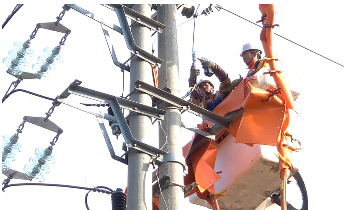
Công nhân Đội Quản lý điện lực khu vực Việt Yên thi công hệ thống lưới điện tại Khu đô thị mới Đình Trám - Sen Hồ, phường Nénh.
