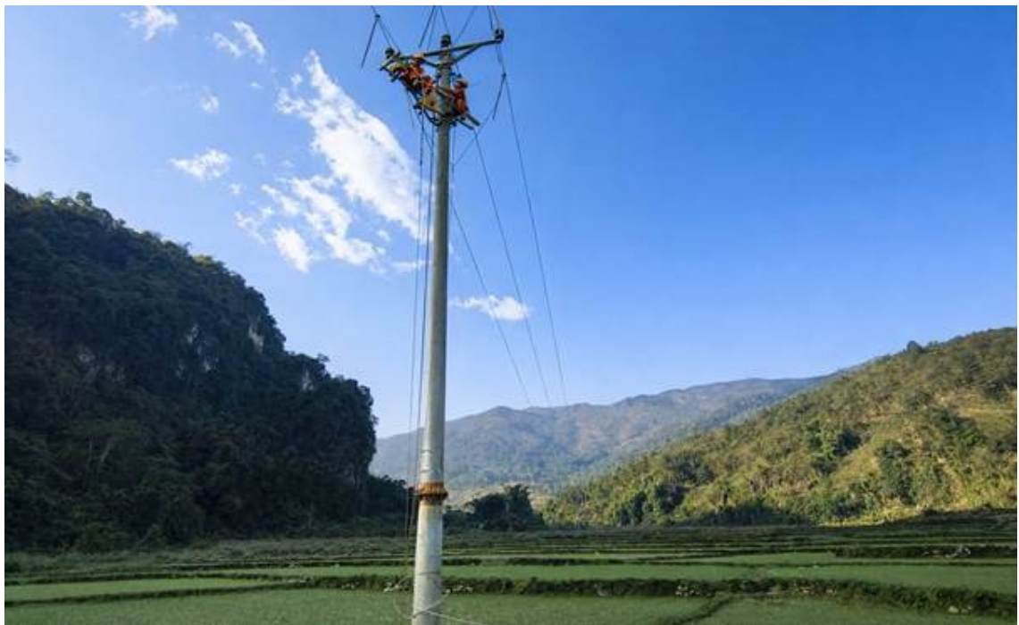
Công nhân đang thực hiện lắp đặt đầu nối, đóng điện vào TBA
