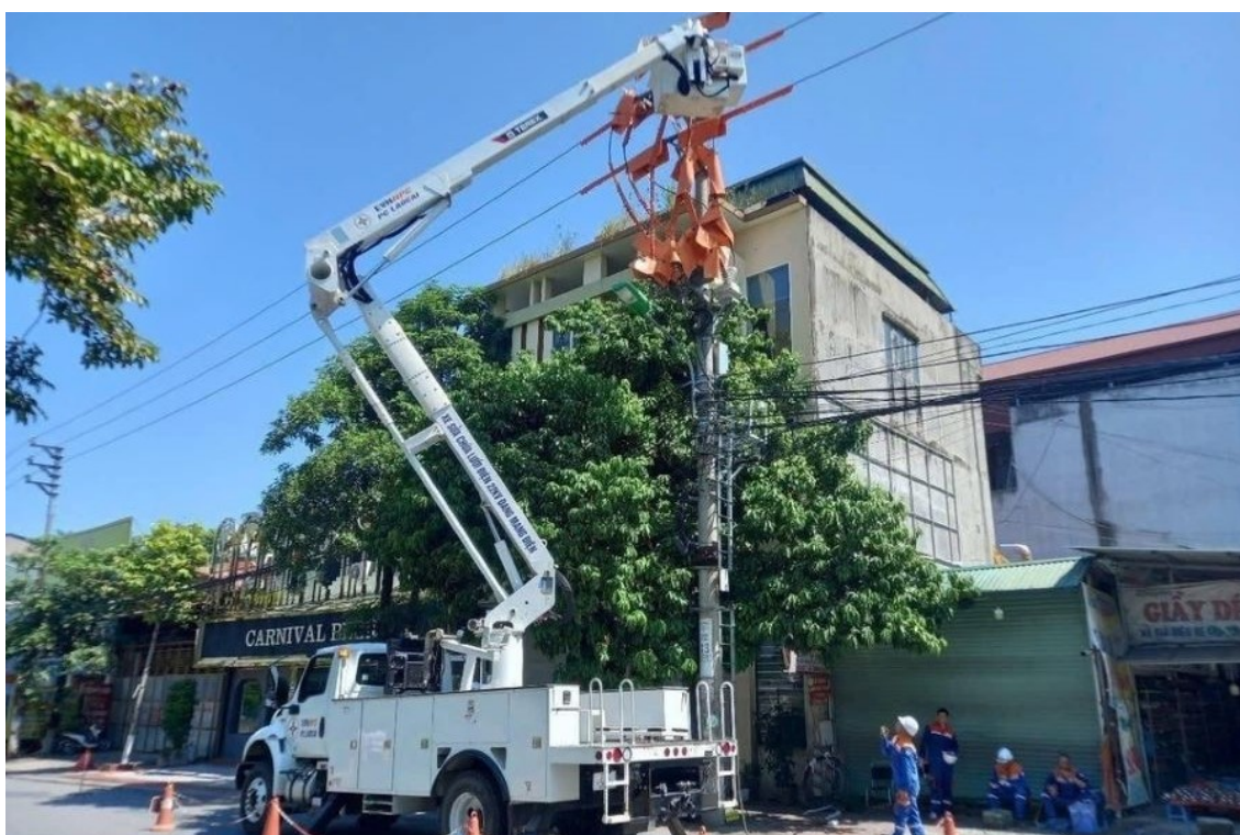
Tăng cường thực hiện sửa chữa điện nóng (hotline) trên lưới điện đang mang điện, hạn chế tối đa thời gian mất điện cho khách hàng
