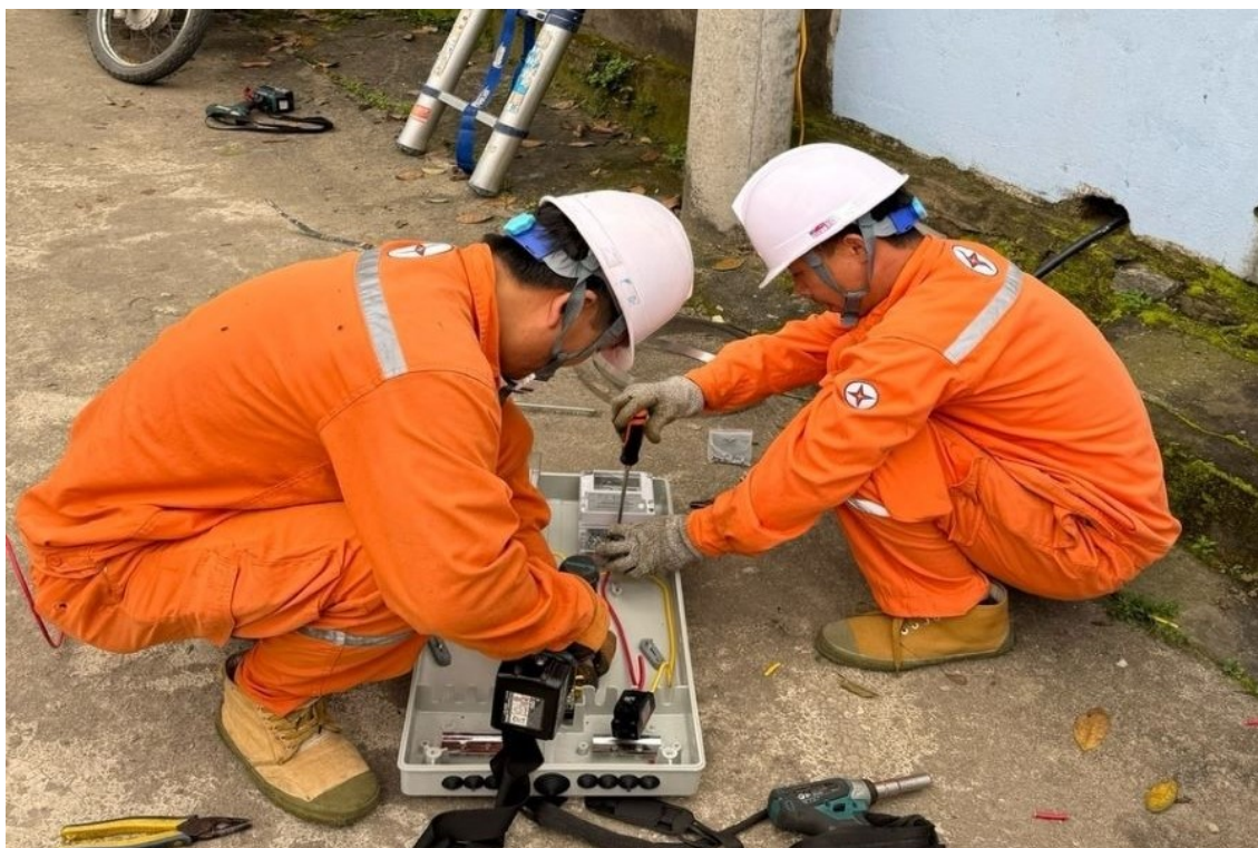
Hệ thống công tơ điện tử được “phủ sóng” giúp khách hàng theo dõi sản lượng điện tiêu thụ minh bạch, chính xác
