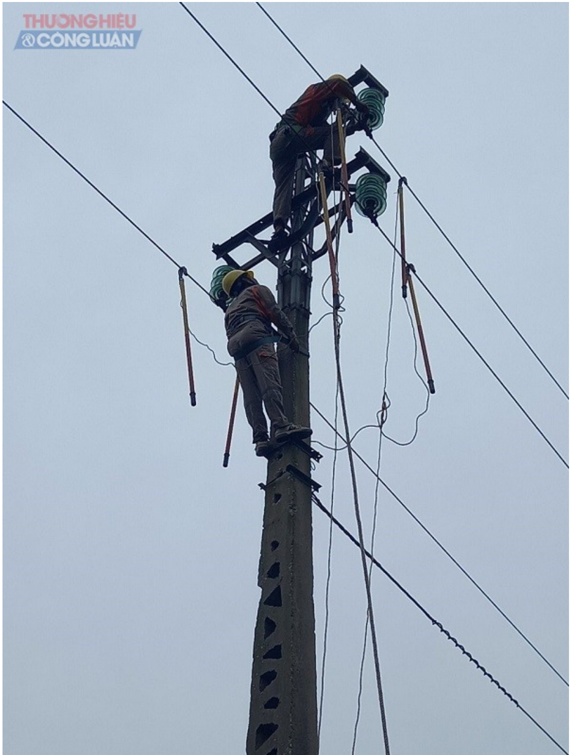
Công nhân Đội quản lý vận hành xử lý sự cố lưới điện sau bão. (Ảnh: Điện lực Hải Phòng)
