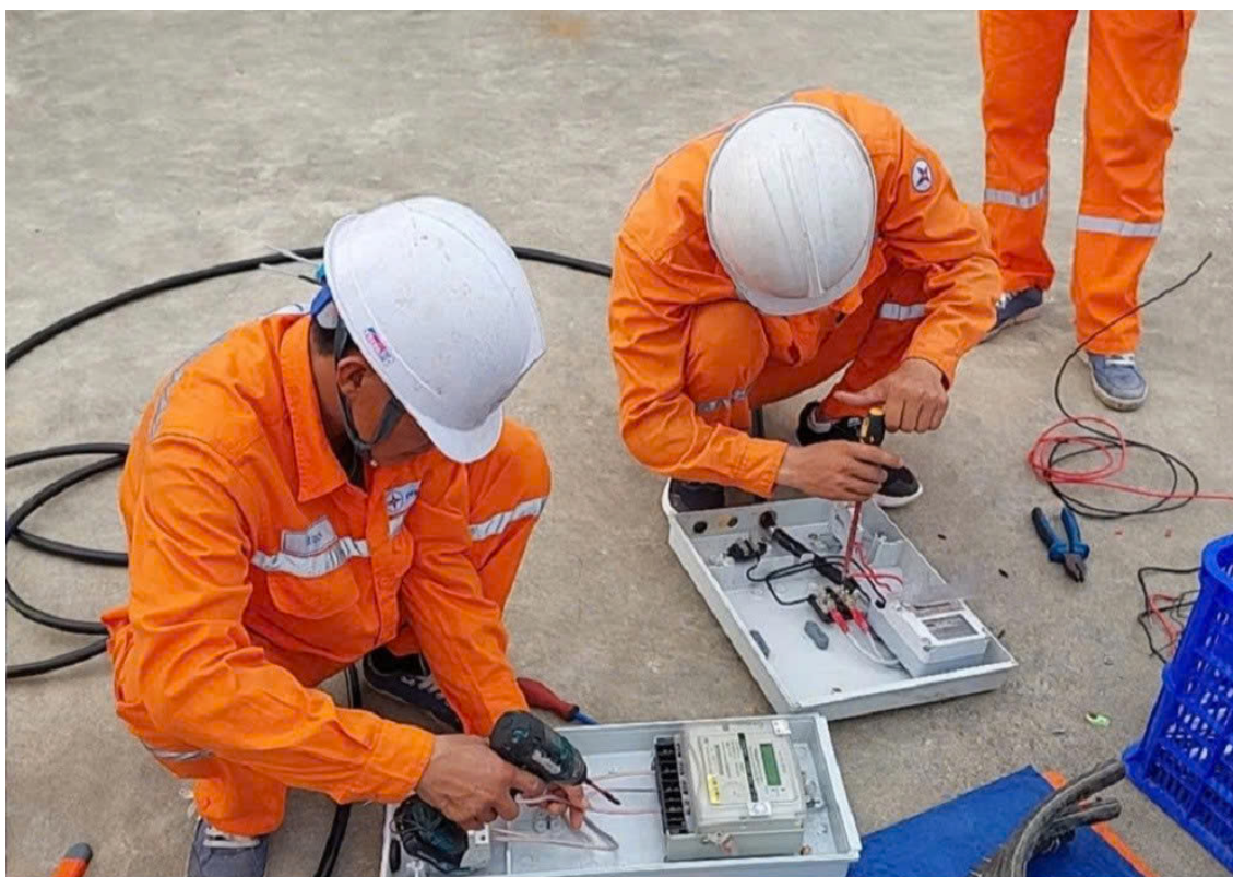
Thực hành lắp đặt công tơ
