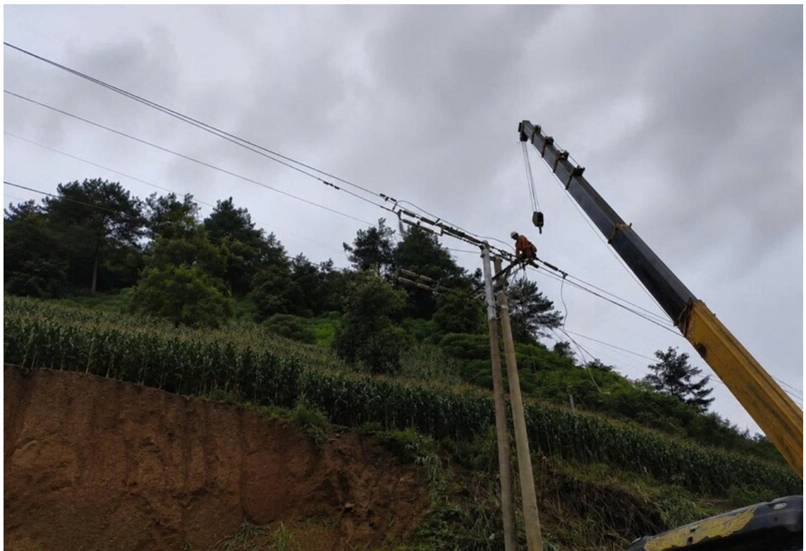
Điện lực Nghĩa Lộ khẩn trương dựng lại cột trung thế số 26 trên đường dây 376E29.2 tại thôn Trống Là, xã Khao Mang, tỉnh Lào Cai. Ảnh:
