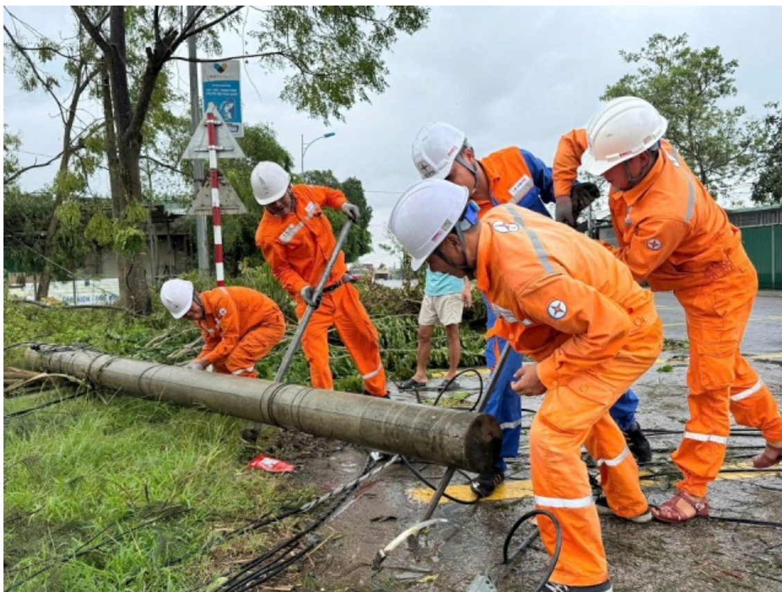
Lực lượng Đội xung kích của các Công ty Điện lực phía Bắc nỗ lực hỗ trợ khắc phục lưới điện tỉnh Nghệ An sau bão.
