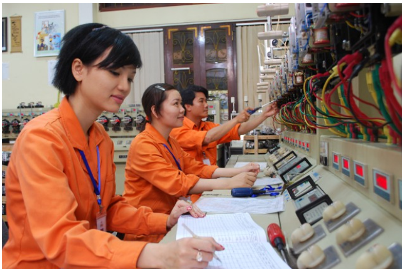
Phòng kiểm định công tơ tại Công ty Điện lực Nghệ An
