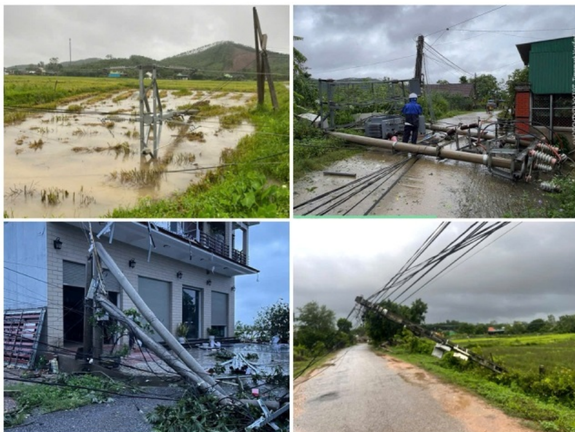
Hệ thống lưới điện trên địa bàn tỉnh Nghệ An bị thiệt hại nặng nề sau bão số 5 (Kajiki).
