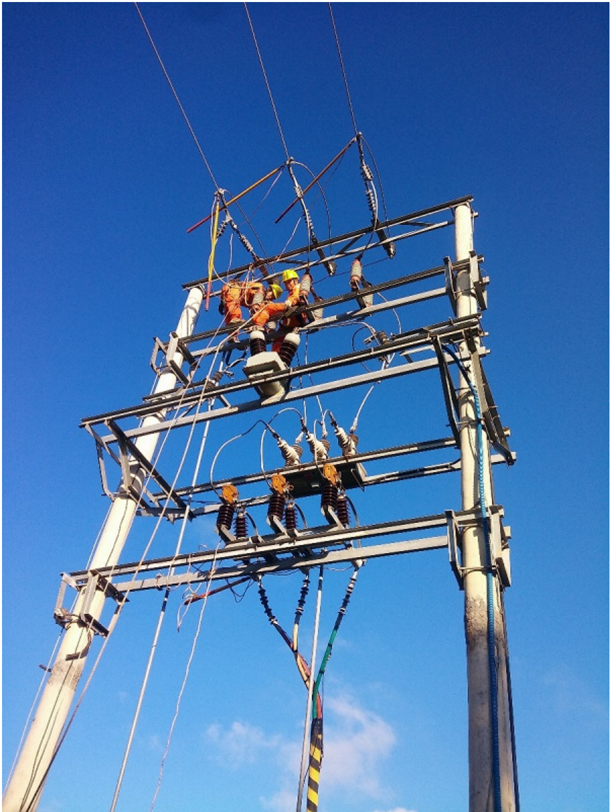
Kiểm tra, xử lý sự cố điện trên đảo Ba Mùn
