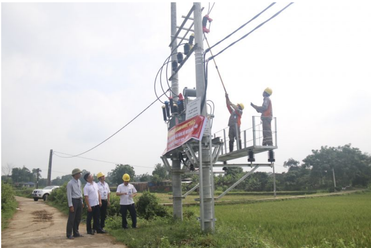
Đóng điện trạm biến áp chống quá tải tại xã Xuân Phương huyện Phú Bình
