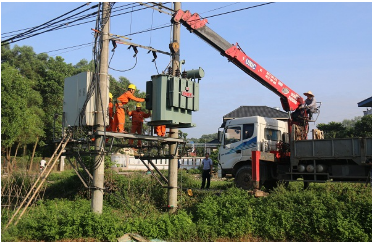
Hoán đổi máy biến áp
