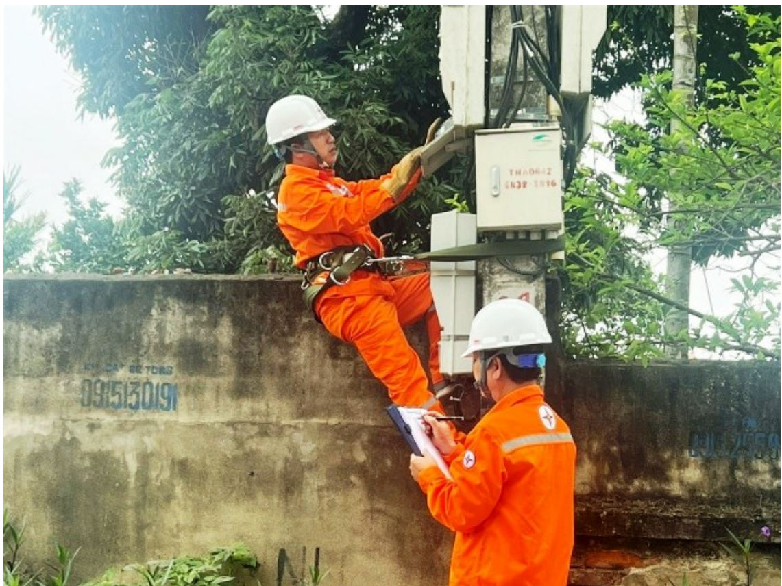
Công nhân Điện lực trực thuộc PC Thanh Hóa đang làm việc
