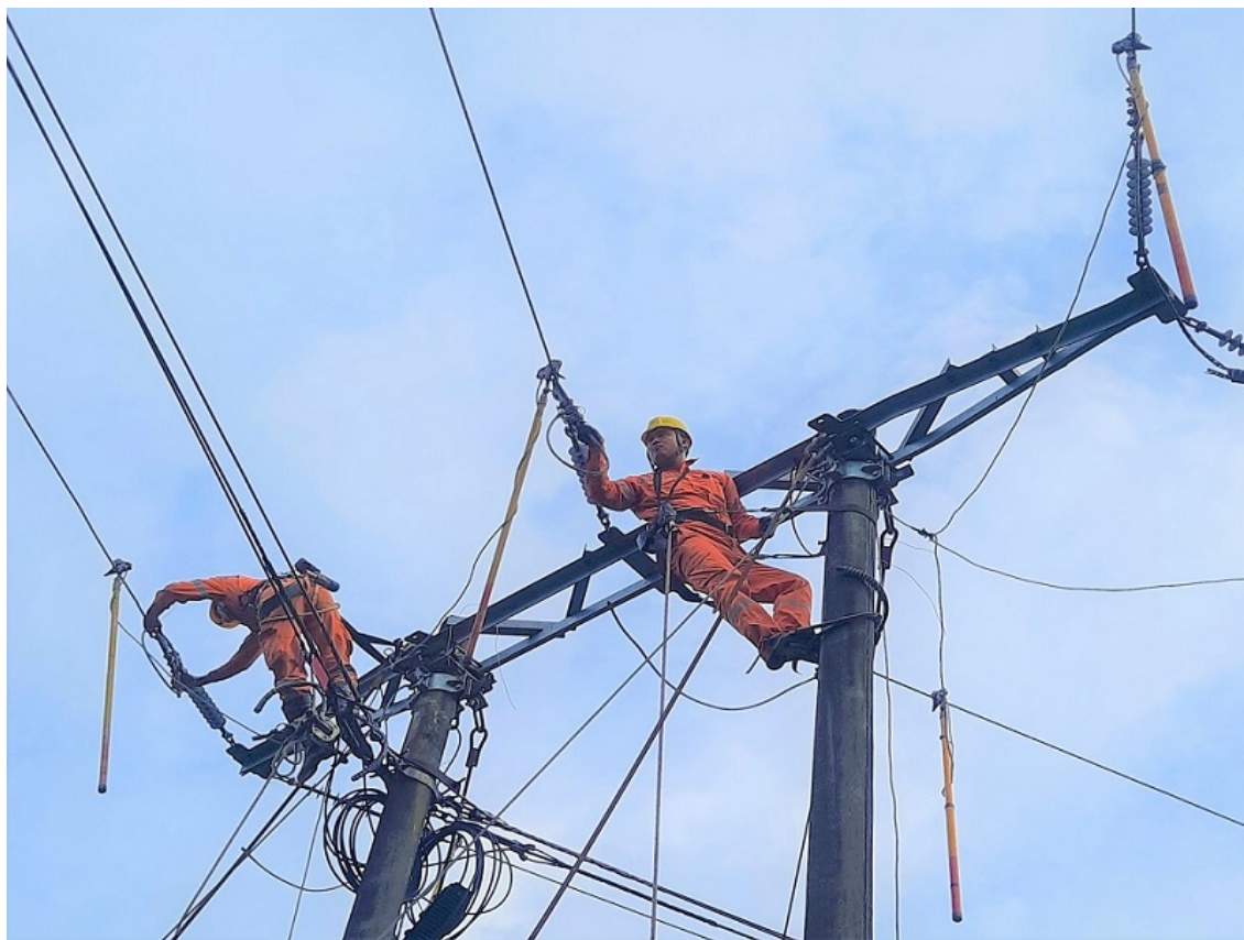
Đội Quản lý vận hành xử lý khiếm khuyết trên đường dây trung thế.
