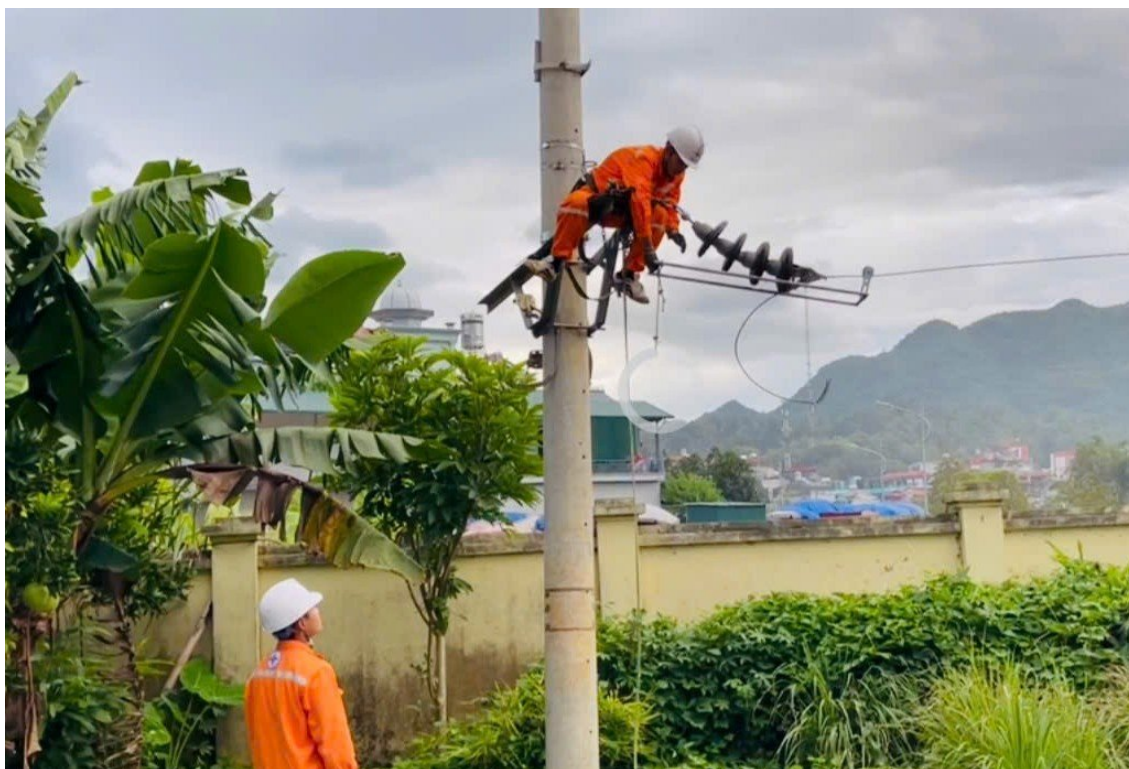
Ứng dụng Giá đỡ hỗ trợ thay sứ chuỗi trên đường dây – Nâng cao năng suất và an toàn lao động
