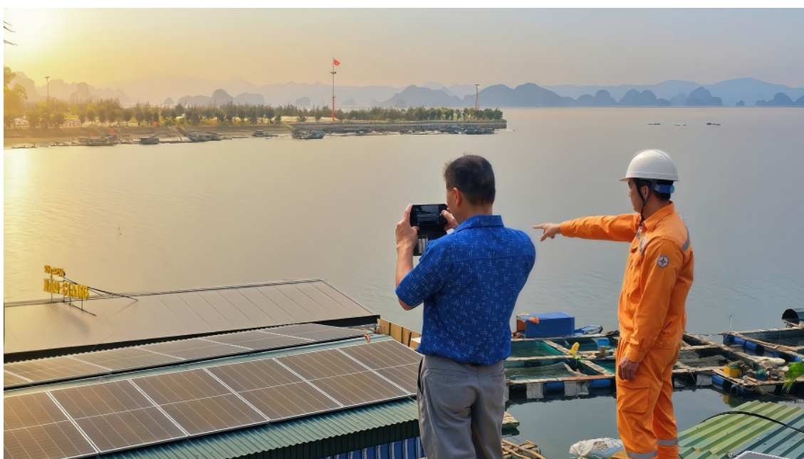
Điện mặt trời mái nhà tại Vân Đồn
