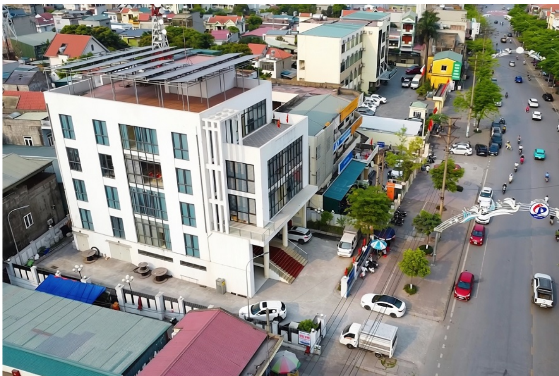
Điện mặt trời mái nhà tại trụ sở Công ty Điện lực
