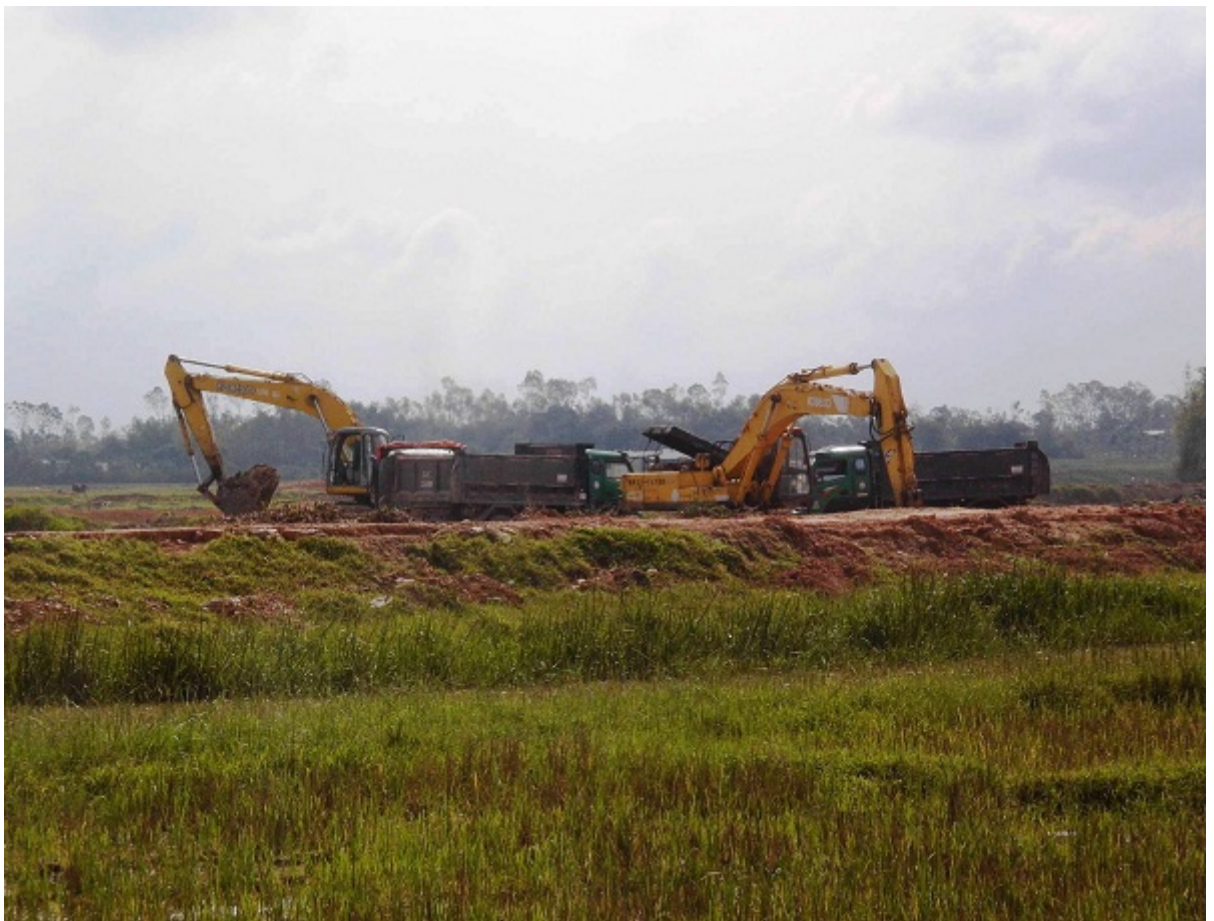
Hai chiếc máy múc và nhiều xe tải được Công ty Tuấn Đạt huy động múc đất tại hồ Đập Hà để bán cho nhà máy gạch
