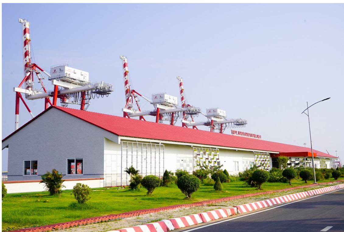
Các công trình tại Cảng Quốc tế Long An sử dụng Ngói tráng men cao cấp Đồng Tâm tạo nên nét đẹp hiện đại nhưng vẫn gần gũi
