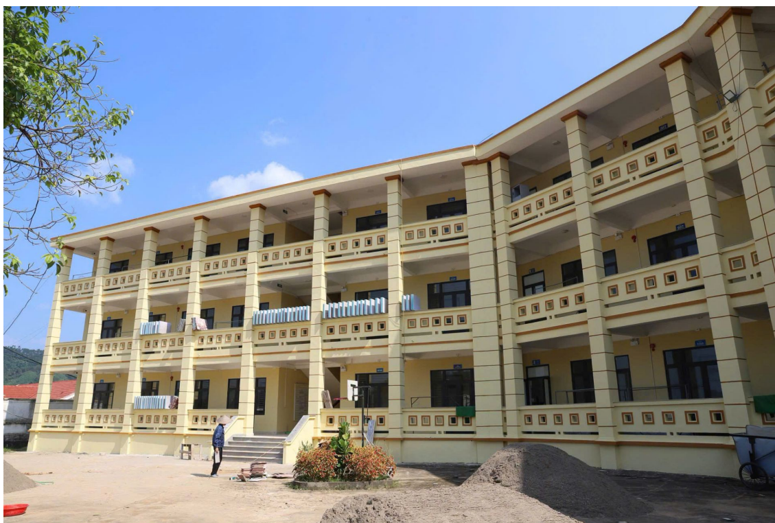
Hạng mục nhà ở nội trú cải tạo 3 tầng đạt 97% khối lượng thi công
