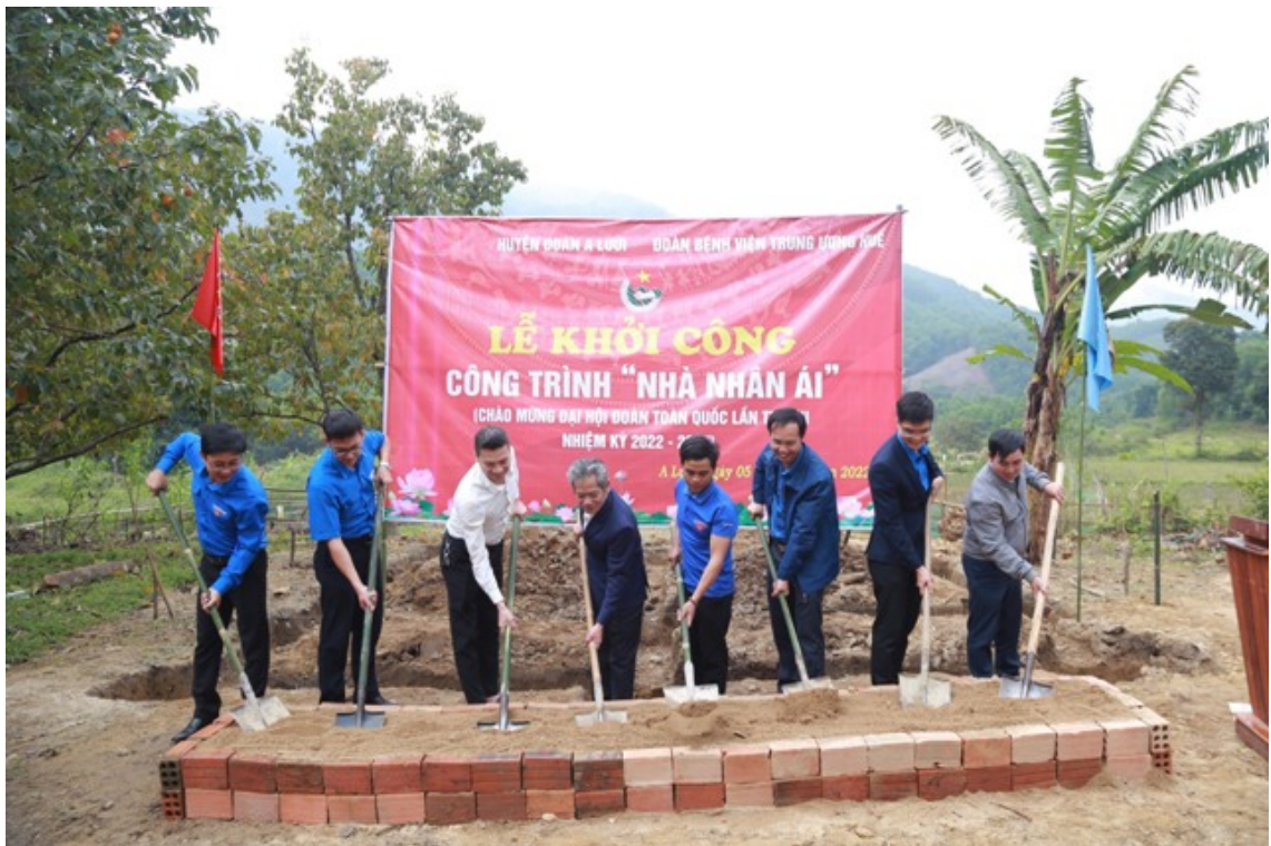
Khởi công xây dựng mái ấm "Nhà nhân ái".
